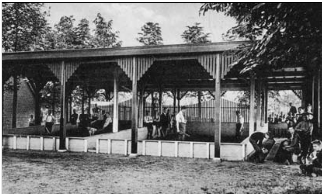
Overdekte beugelbaan Julianazaal van Teune Jan. Op vrij eenvoudige wijze wordt de zaal na het beugelen weer geschikt gemaakt voor toneel- of muziekkuitvoeringen of dansgelegenheden.
